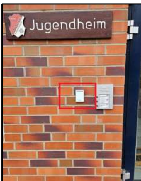
Kontaktfläche Transponder Haupteingang (EG)
